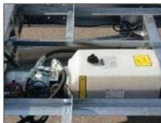
Bild 1.2: Kunststofftank / Ausf.: Elektro-&amp;Kombipumpe
